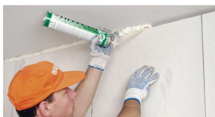
Высота плит последнего ряда должны быть на 2-3 см меньше расстояния между кромкой предпоследнего ряда и потолком для того, чтобы можно было выполнить эластичный шов. Выложите последний ряд блоков. Зафиксируйте стену клиньями, вбиваемыми в зазор между кладкой и потолком. Заполните зазор монтажной пеной. Дайте пене схватиться и обрежьте лишнюю пену ножом.
