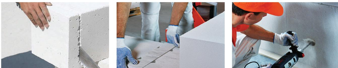
Теперь заполните паз(ы) на блоках в вертикальных швах и переставьте шнур-причалку на одну ступень выше (см. картинки в начале страницы). Затем следует установка следующего ряда блоков, и все повторяется до тех пор, пока Вы не дойдете до верхней отметки высоты оконных и дверных проемов. Как правило, кладку следует армировать через каждые четыре ряда и обязательно после первого ряда блоков. Арматура также укладывается под оконными проемами и на опорной поверхности перемычек (900 мм).
