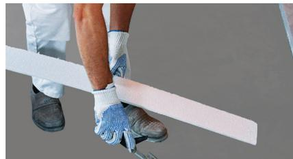
Определите место для перегородки и отметьте его на стенах и на полу. Проверьте ровность пола и при необходимости выровняйте его. Приклейте к полу полоску пенополистирола толщиной 10 мм и шириной с перегородочную плиту. Для облегчения кладки стены прикрепите к имеющейся стене вертикальную опору, а к полу доску. Приготовьте КЛЕЙ ДЛЯ ЯЧЕИСТОГО БЕТОНА **bauroc** согласно инструкции на упаковке клея.
