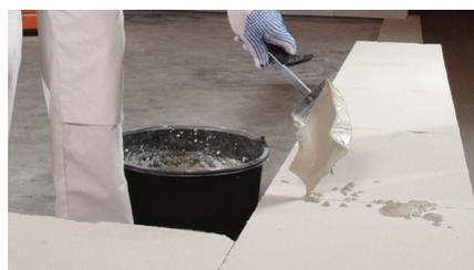
Залейте воду в емкость и добавьте КЛЕЙ baugoc. Приготовьте подходящую клеевую смесь согласно инструкции на упаковке клея. После этого заполните клеем имеющиеся на торцах блоков пазы, чтобы обеспечить герметичность вертикальных швов.
