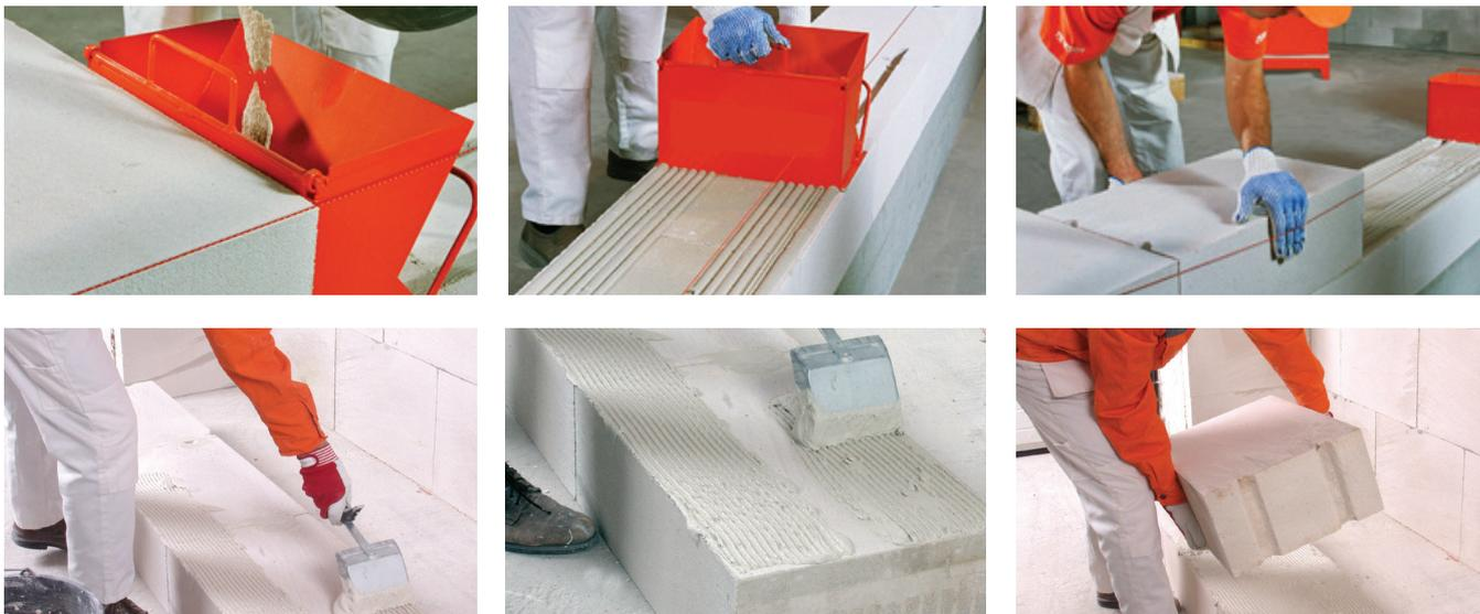
Исходя из ширины блока, выберите каретку для клеевого раствора подходящей ширины и влейте в неё КЛЕЙ ДЛЯ ЯЧЕИСТОГО БЕТОНА bauroc. Каретка поможет нанести клей на поверхность блоков равномерным слоем. Клей можно наносить на блоки также при помощи ковша для клеевого раствора. Летом рекомендуется немного смачивать поверхность блоков перед нанесением клея.
