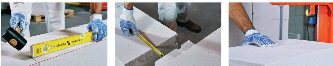
Наиболее точно блоки можно распилить электрической ленточной пилой, но и ножовкой блоки bauroc легко пилятся до необходимого размера. При установке неполномерного блока следите за тем, чтобы в каждом вертикальном шве хотя бы на одном блоке имелся(ись) паз(ы). После того, как клей достаточно затвердеет, при необходимости сгладьте поверхность блоков теркой и удалите щеткой образовавшуюся пыль.
