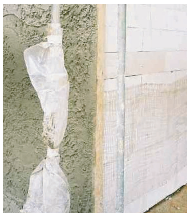
1. att. Cokola apdare. Siena nav gruntēta, sieta iestrādāšanas tehnoloģija nepareiza, jo sietu vajag iespiest svaigi uzvlīktā armējošās javas kārtā
