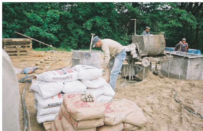
2. att. Ārējās apdares apmetuma izgatavošana būvlaukumā. Tehnoloģija lēta, bet primitīva, bez jebkādas sastāva kontroles. Nekādas kontroles nav arī Saulkalnes rūpniecībā izgatavoto kaļķu veldzēšanā metāla mucā. Tas arī parasti ir apmetuma atslāņošanās un plaisāšanas iemesls
