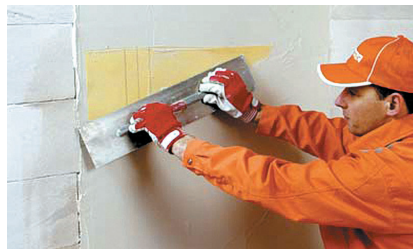
4. att. Stiegrojošā stiklšķiedras sieta nosešana ar armējošo javu KAM
