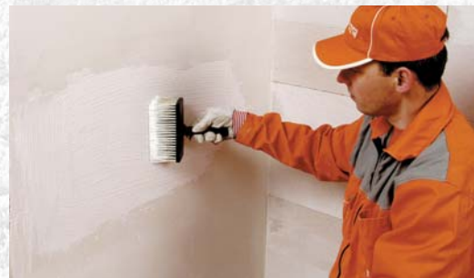
Nožuuvušu armējošās javas kārtu nogruntē ar grunti PG
