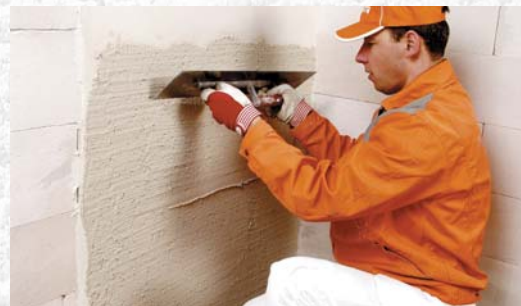
Plānā kārtā uzvelk dekoratīvo apmetumu
