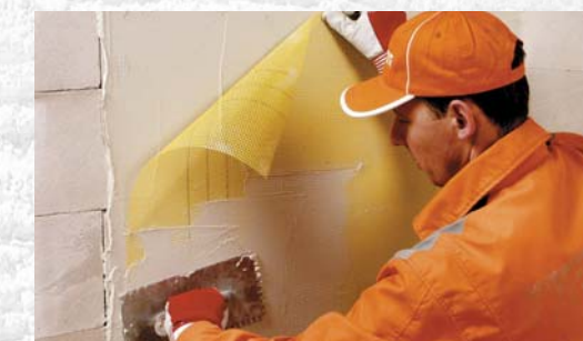
Svaigi uzvilkta armējošās javas kārtā iespiež armējošo sietu
