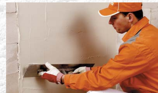
Plānā kārtā uzvelk armējošo javu KAM, kas satur polipropilēna šķiedru armējumu
