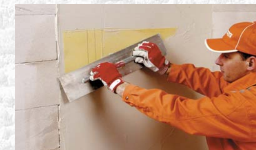
Armējošo sietu nosedz ar plānu armējošās javas KAM kārtu
