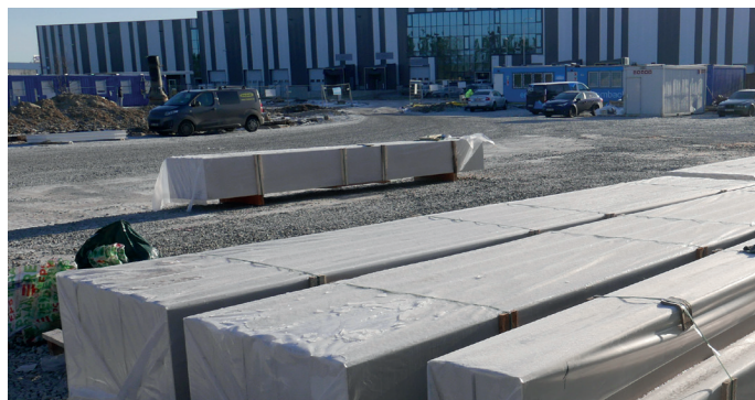
Objektile toodud paneelid peavad olema sademete eest kaitstud
