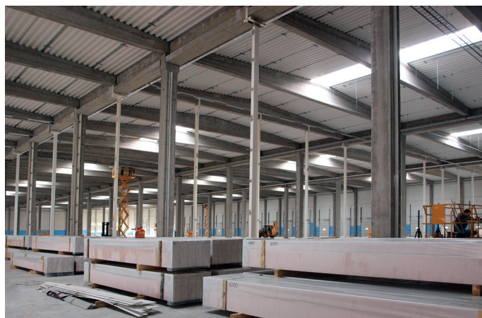
Складирование на бетонный пол
