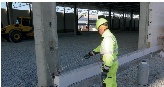
Поверхности, покрытые изморосью, перед нанесением клея следует прогреть
