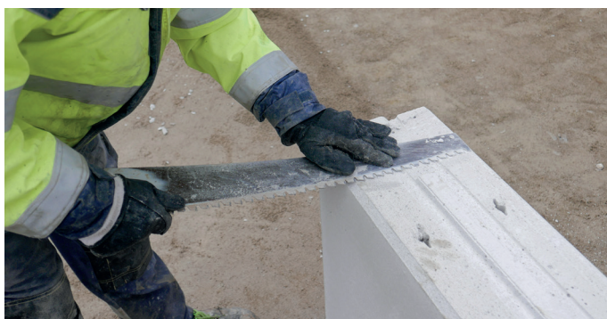
Крепление анкером и фрезеровка углублений
