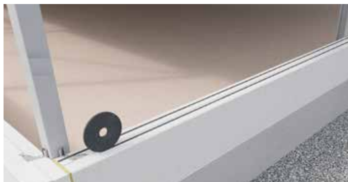
Montāža, izmantojot blīvēšanas lenti.
