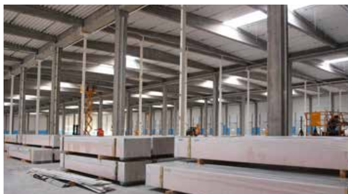
Izkraušana uz betona grīdas.
