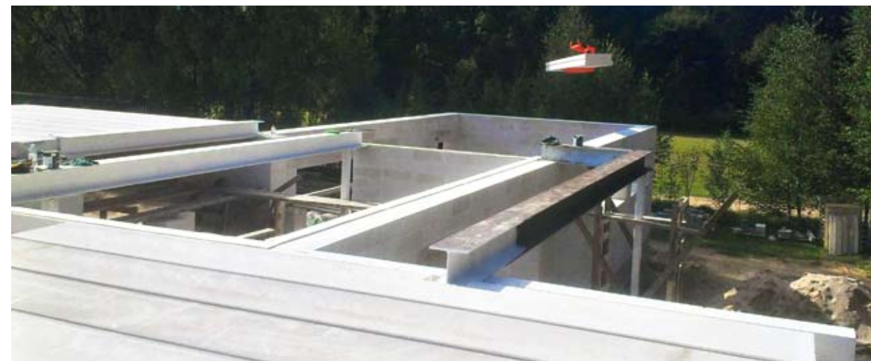
Pārseduma panelu montāža.
