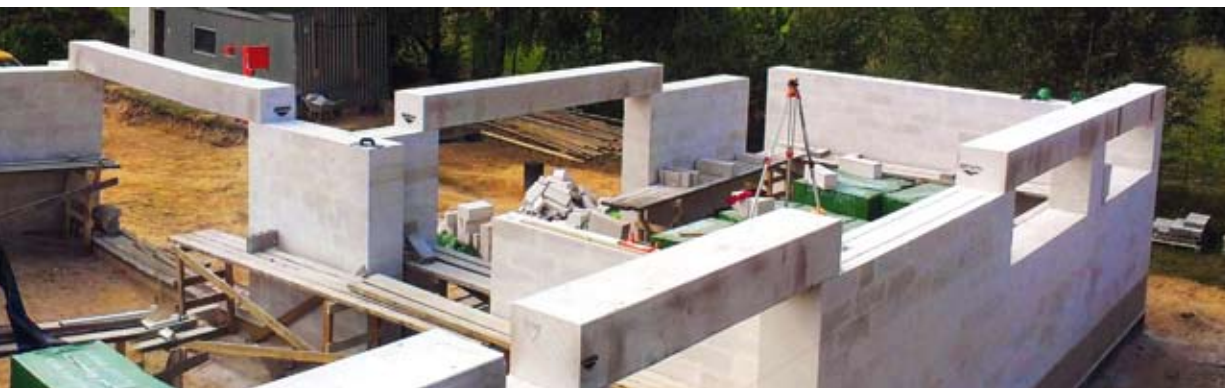
Armēto pārsedžu montāža.
