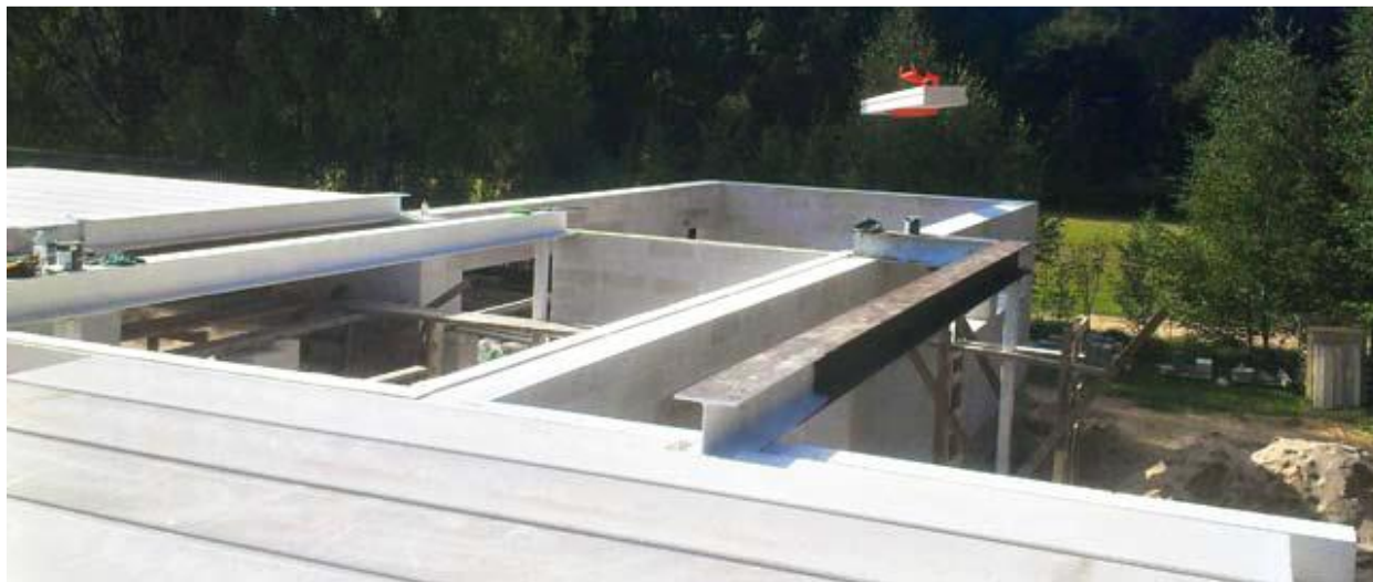
Монтаж панелей перекрытия.
