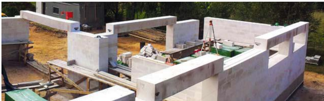
Монтаж армированных перемычек.
